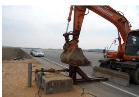
가) 지주 시험체 설치
