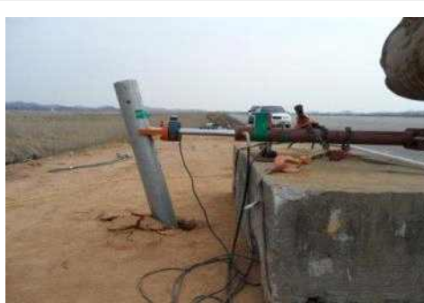
나) 지주 시험 후
