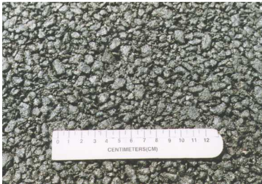
〈그림 2〉 개립도 마찰층의 표면 상태
