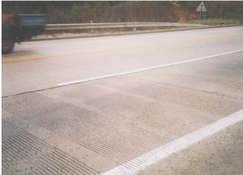
〈그림 5〉 그루빙 시공 후의 표면 상태
