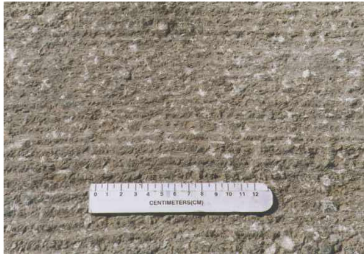
<그림 7> 노면 평삭 후의 표면 상태
