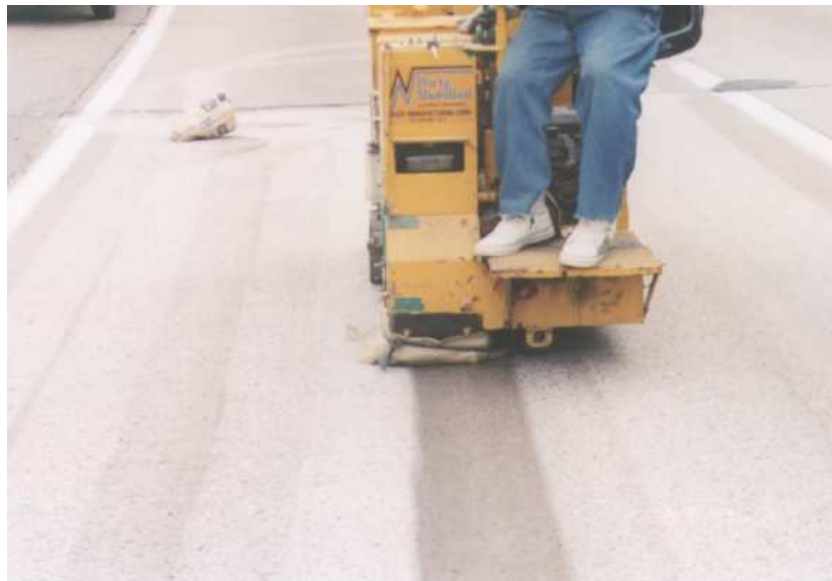
〈그림 6〉 슛 블라스팅 시공 후의 표면 상태
